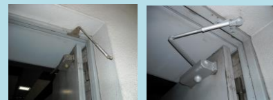
ドアローザ交換修理
