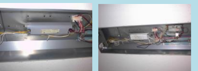
照明器具安定器交換修理
