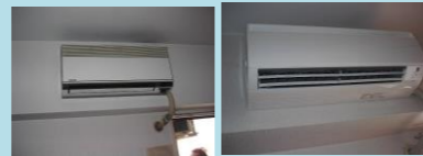
ルームエアコン更新
