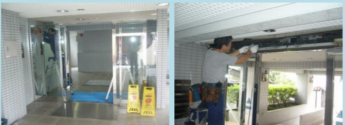
自動ドア更新工事
