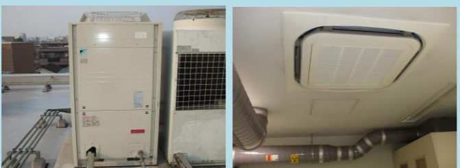
空調設備更新工事
