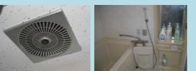
換気扇交換修理
