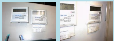
空調リモコン交換修理
