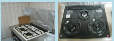
ガスロン交換修理
