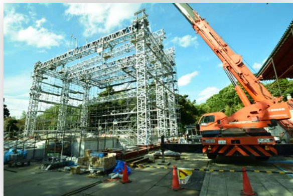
(素屋根工事中)
