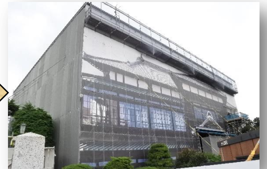
(素屋根工事完成時) 2016年9月21日現在
