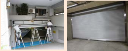
シャッター更新工事
