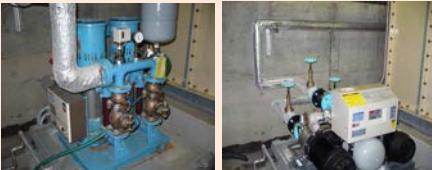
給水設備更新工事
